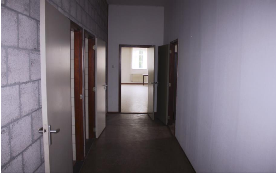
De middengang op de verdieping aan de westzijde van het gebouw, gezien richting het oosten.
