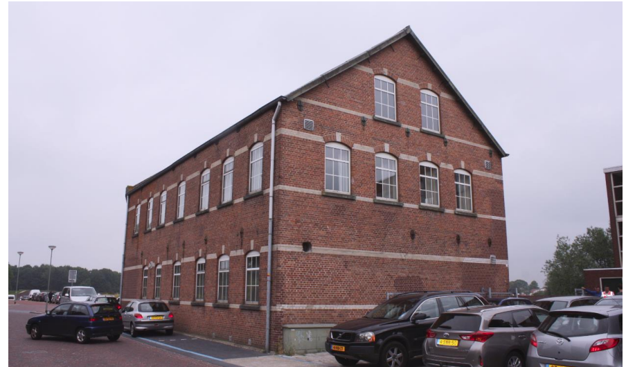
Zicht op de oostgevel.
