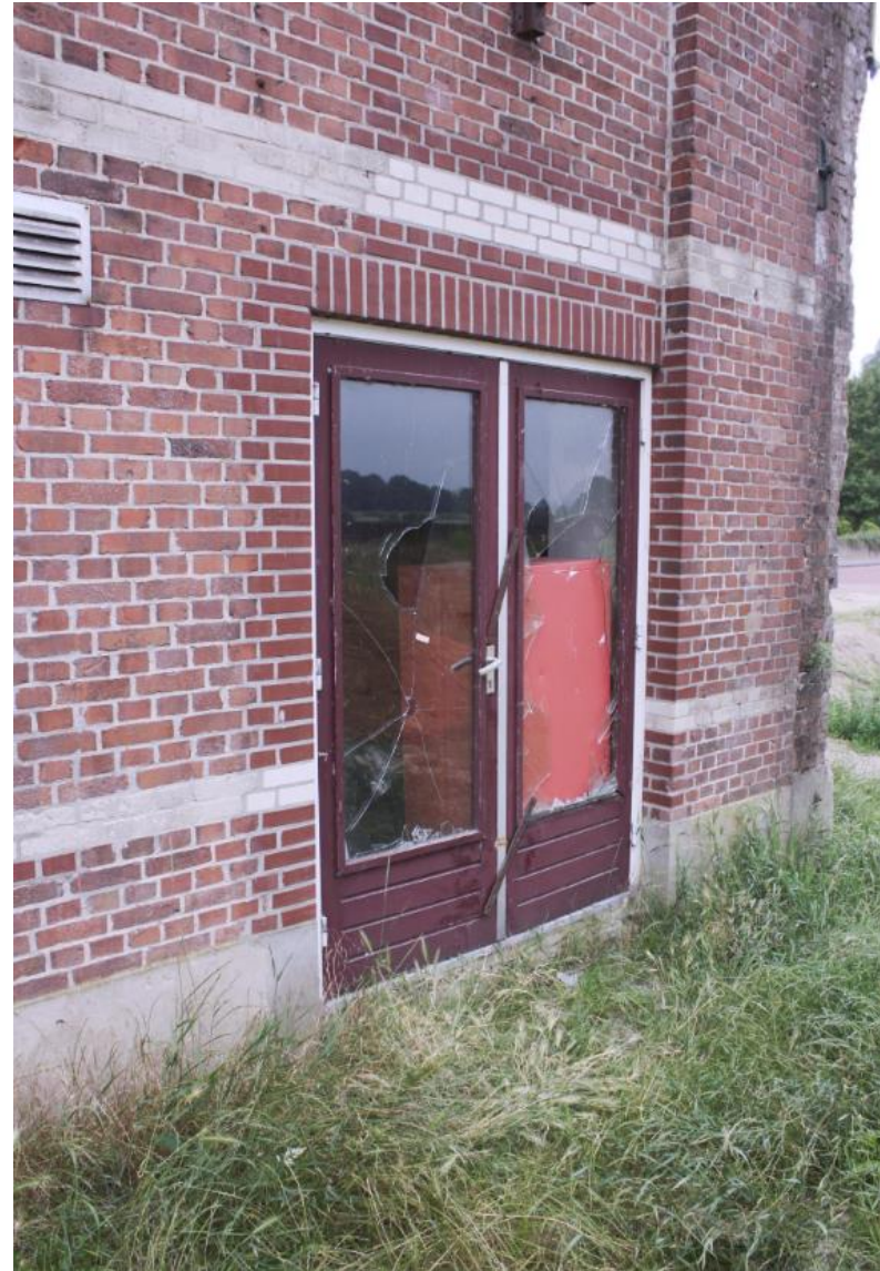
Huidige entree in de zuidgevel uit 1983.
