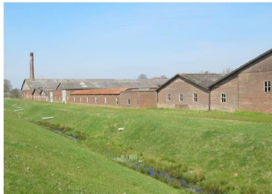
De zuidgevels van de bouwclusters gezien vanaf de dijk. FH MAB 2014
