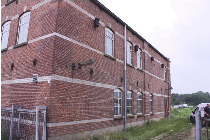
Zicht op de noordgevel met het vulwerk in de voorste hoek ter plaatse van de voormalige loopbrug.
