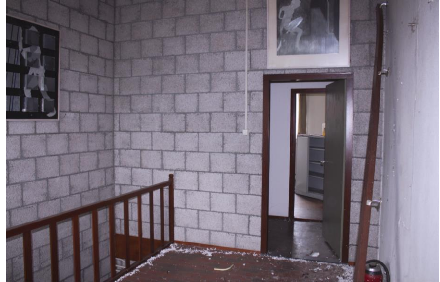
De overloop op de verdieping aan de westzijde van het gebouw, met zicht op de middengang.
