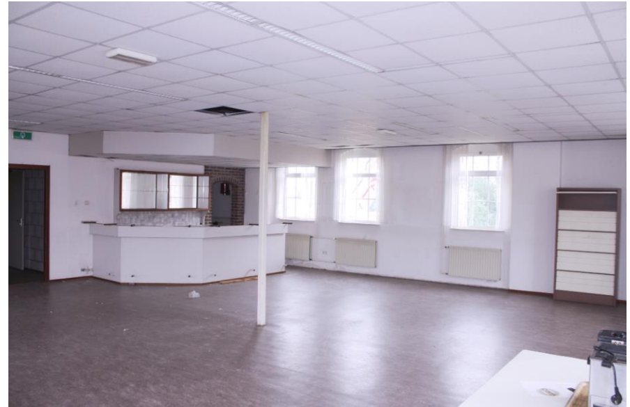
De ruimte aan de oostzijde van de verdieping, gezien richting het noordwesten.
