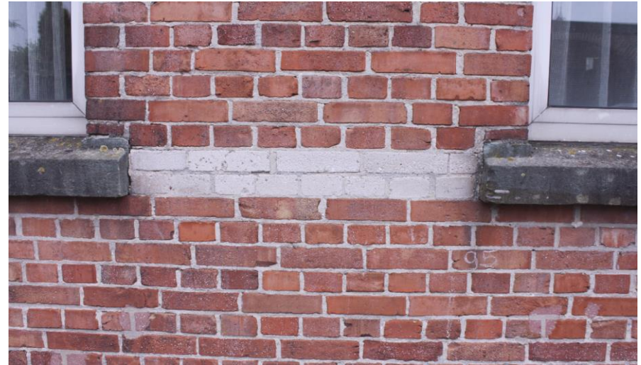
Detail van de spekband op de begane grond in de zuidgevel.
