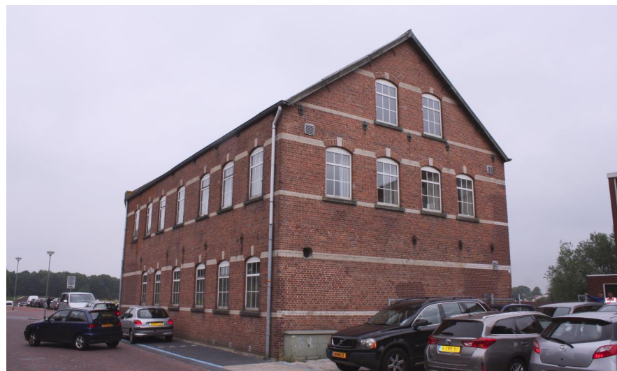
Zicht op de oostgevel.
