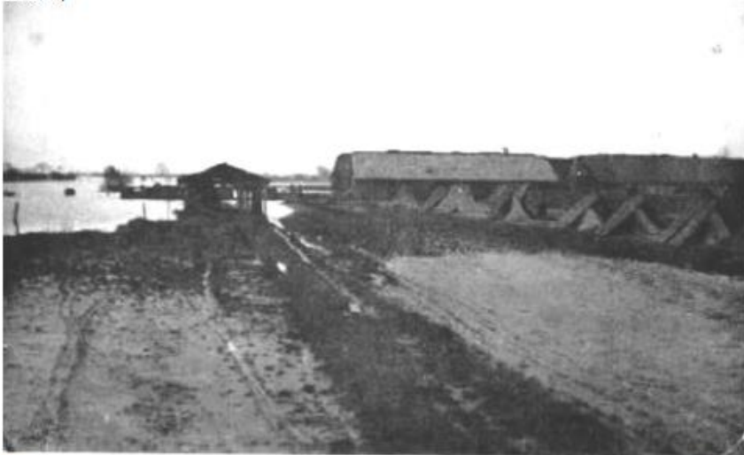
De uiterwaarden met veldoven en droogbanen gefotografeerd in 1926 toen de Maas geleidelijk aan na de catastrofale overstroming in zijn bedding was teruggekeerd. (foto uit De Alde Milsbèk)
