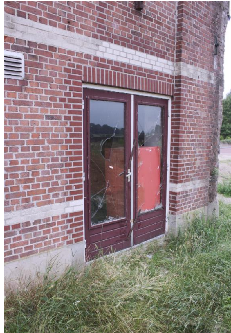
Huidige entree in de zuidgevel uit 1983.
