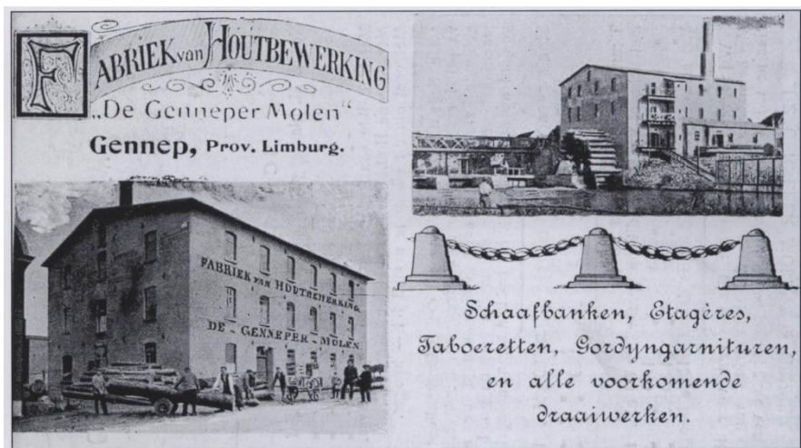
Advertentie uit omstreeks 1900 van de Fabriek van Houtbewerking met zichtbaar het molengebouw.
