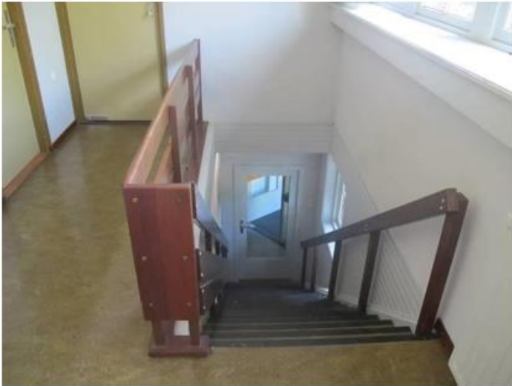
Niet oorspronkelijke trap naar de verdieping van het hoofgebouw. (MAB, 2011)
