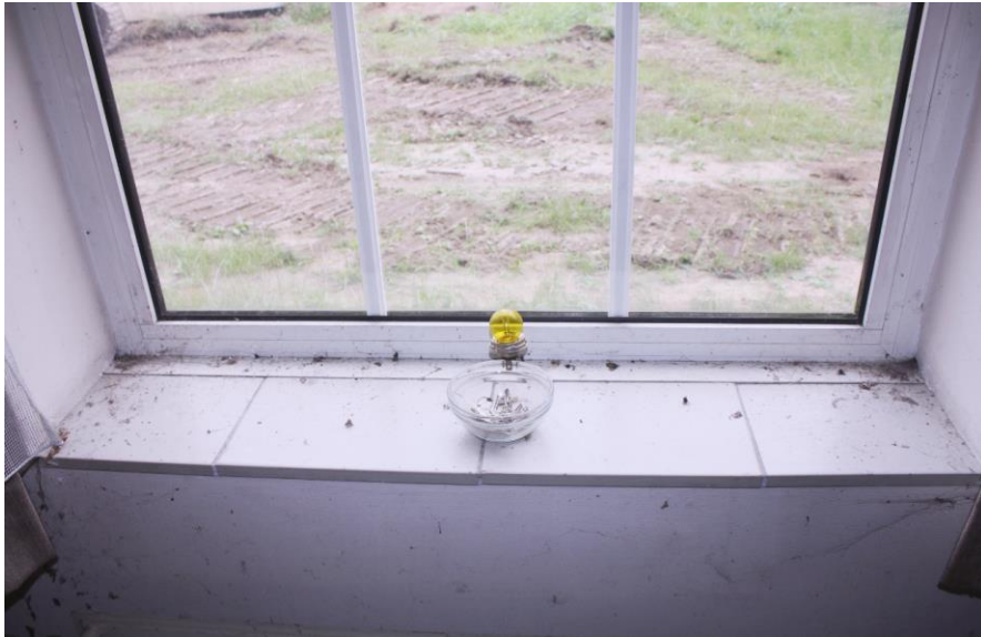
Bij de vervanging van de ramen in 1983 zijn ook de vensterbanken vernieuwd.
