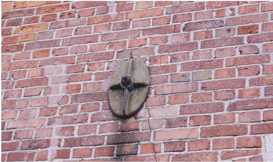
Rozetanker in een van de gevels.
