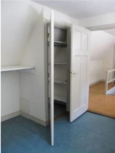
Oorspronkelijke houten paneeldeuren en afgeronde kozijnen op zolder, hoofgebouw (MAB, 2011)
