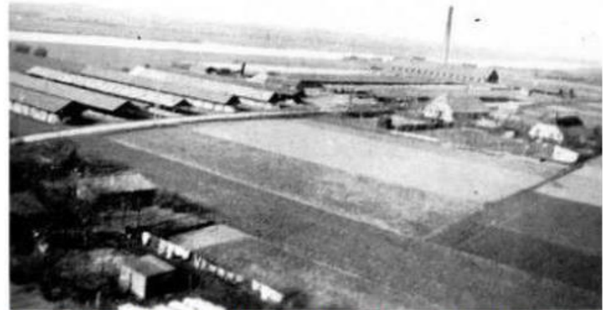
Vogelvlucht van de N.V. Steenfabriek Milsbeek in 1943, gefotografeerd vanuit een toen net gereed gekomen electriciteitsmast door Frans Huisman. Links op de voorgrond de reeksen haaghutten en op de achtergrond de ringoven met schoorsteen. (foto uit De Alde Milsbèk)
