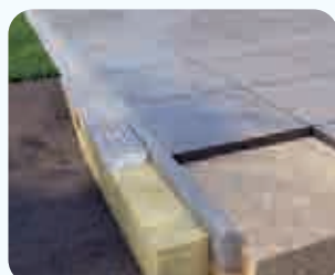
Infiltreren onder een kiezelgoot
